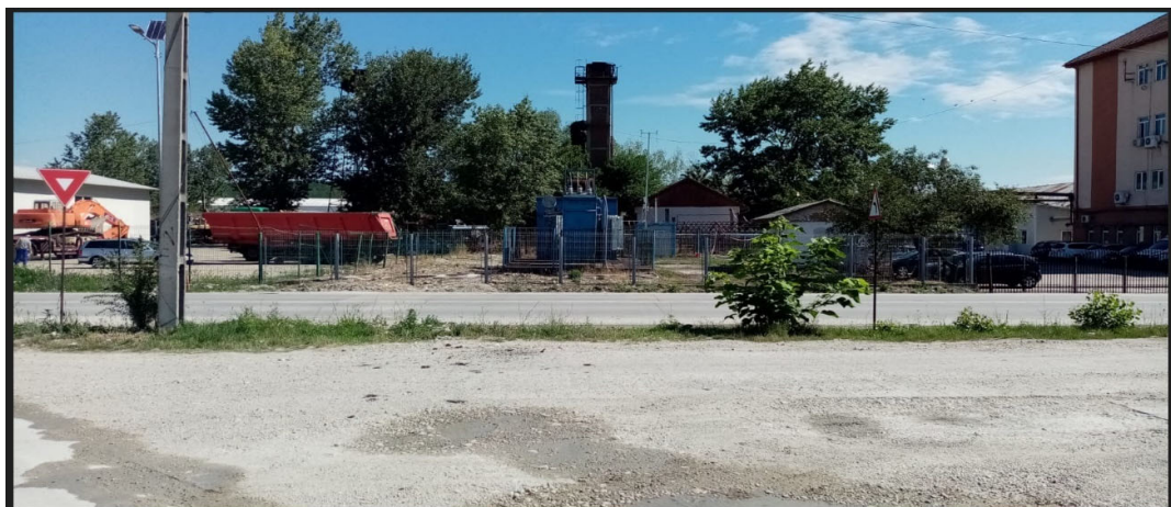
Figura nr. 2-31 Situația actuală din zona de amplasament a Stației GJ-2 , 18.07.2022
